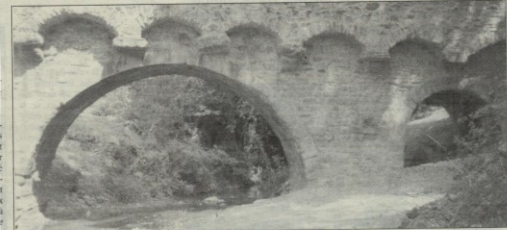
Le Pont de la Font que but, à Autichamp, datant du XVII e siècle, a été entièrement rénové (longueur : 35m, largeur : 2,55 m).
