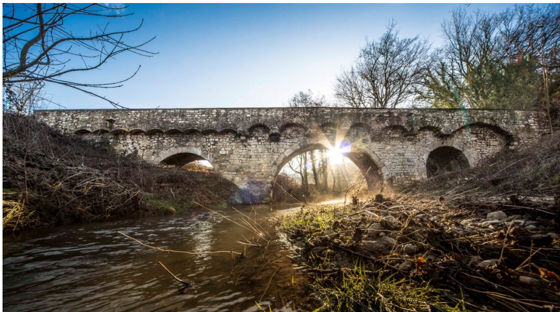
Face coté aval
